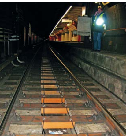
Austria | Wiener Linien Vienna | Podkłady z FFU na gumowych stopach w tunelu
