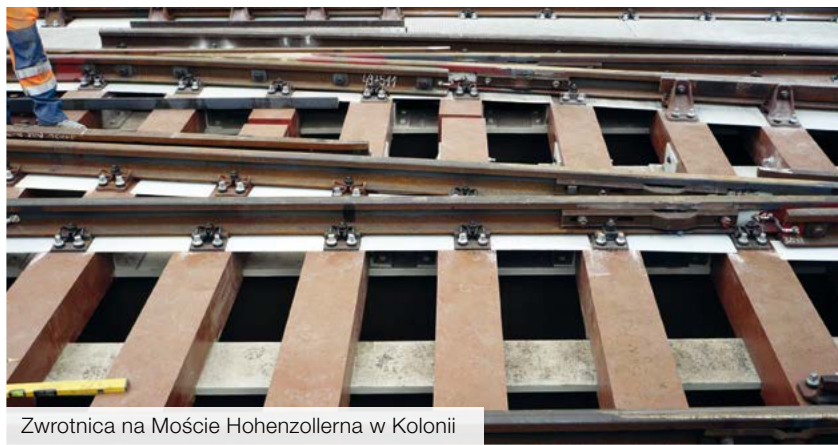
Specjalne zamocowanie podkładu z FFU na ażurowej konstrukcji stalowej
