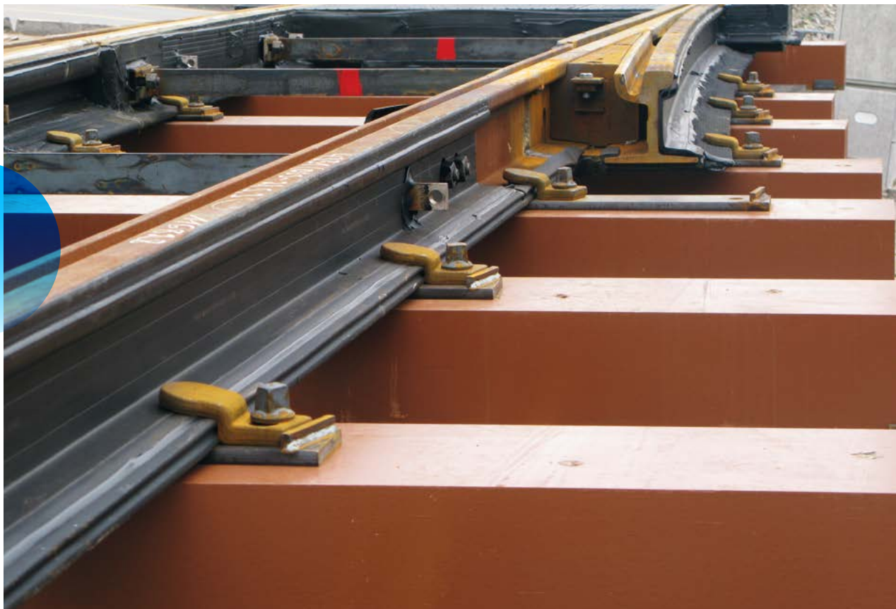
MVV Monachium | Zamocowanie „Rheinfeder” na podkładzie z FFU
