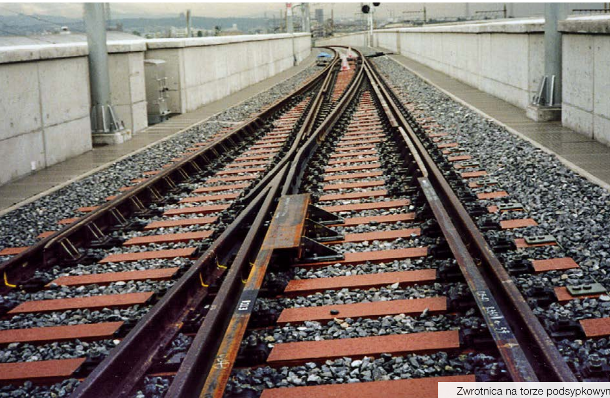
Zwrotnica na torze bezpodsypkowym, przykręcana, na gumowych stopach
