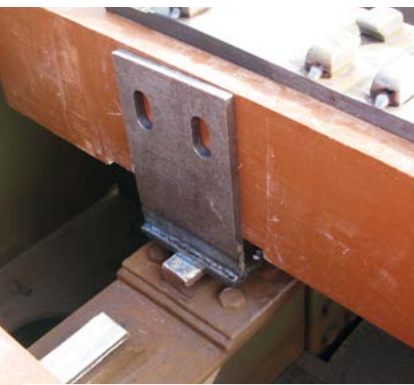
Specjalne zamocowanie podkładu z FFU na ażurowej konstrukcji stalowej
