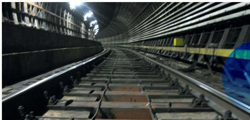
Austria | Wiener Linien Vienna | Podkłady z FFU na gumowych stopach w tunelu
